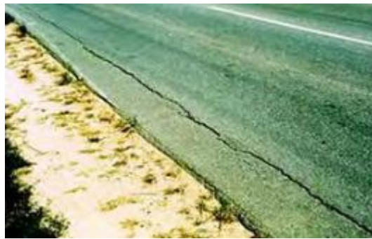
Gambar 2.11 retak Samping
