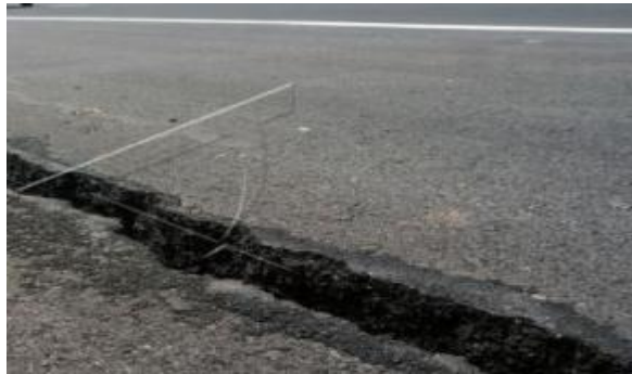
Gambar 2.13 Bahu Jalan Turun
