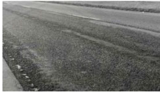
Gambar 2.16 Pengausan Agregat
