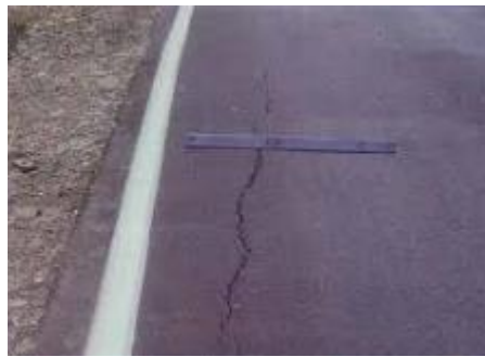
Gambar 2.14 Retak Memanjang
