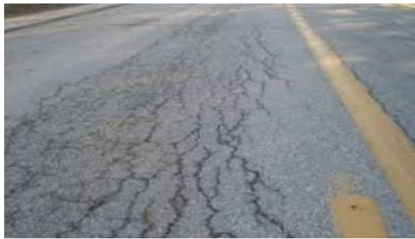
Gambar 2.5 Retak Kulit Buaya
