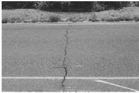
Gambar 2.12 Retak Sambung
