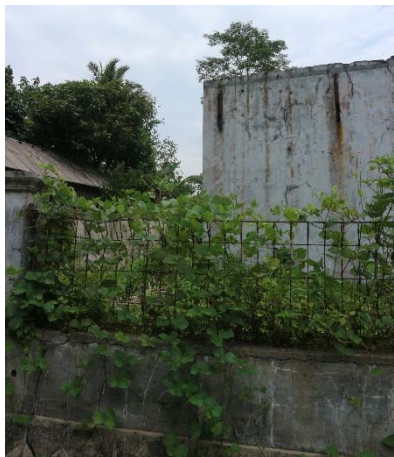
Gambar II.9. Rumah Tembok yang ambruk di Kampung Adat Kuta Sumber: Dokumen pribadi (2021)
