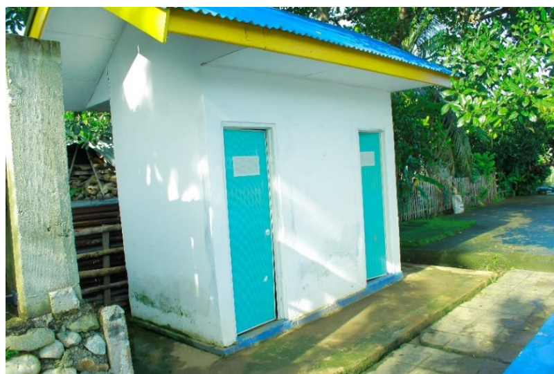
Gambar II.11 Toilet di Wisata Tebar Rukis Sumber: Dokumentasi Pribadi (15/01/2020)
