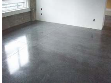
Gambar 5.28 Lantai Beton Ekspos (Sumber: Google Images)
