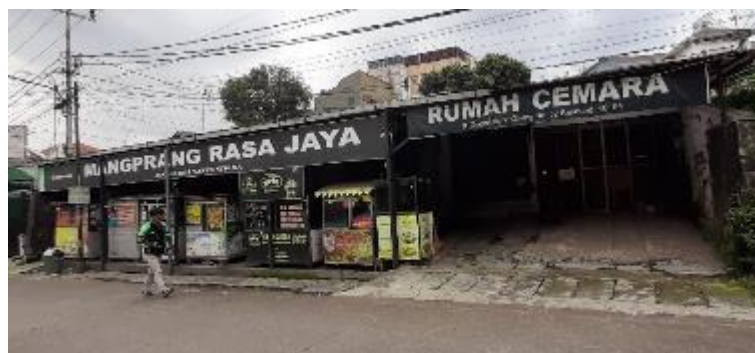
Gambar II.23 Lokasi Rumah Cemara Sekaligus RCBC Sumber: Dokumen Pribadi (diambil pada: 29 April 2020)
