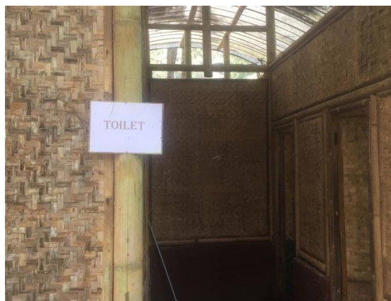
Gambar II.34 Identifikasi Toilet Sumber: Data Pribadi (2019)
