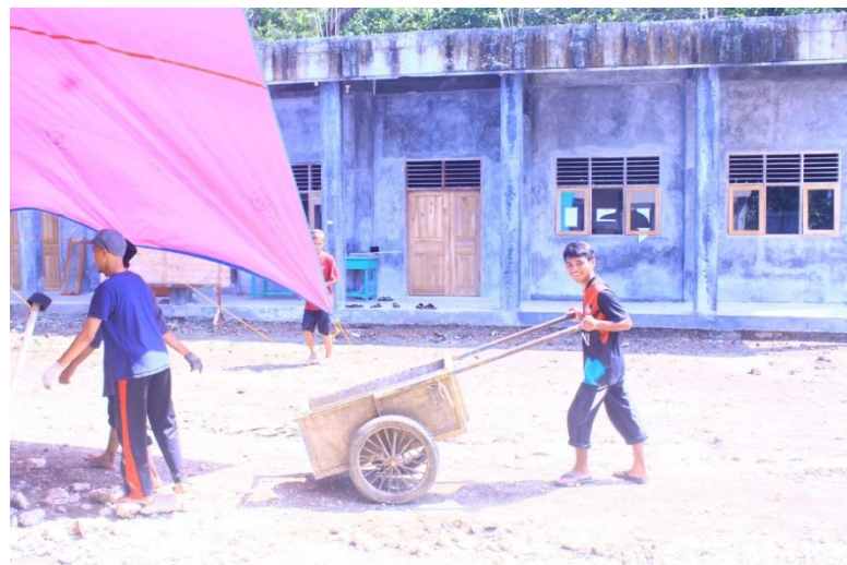
Gambar: II.11 Pembangunan Gedung SMP Tunas Pertiwi Sumber: Data Pribadi
