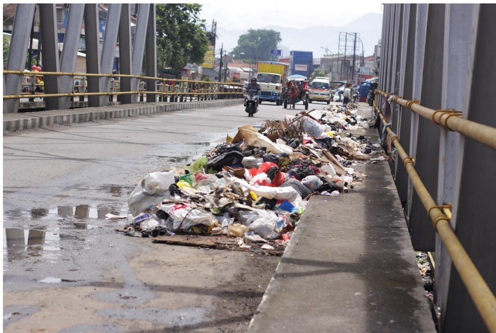
Gambar II.15. Kondisi Sampah Jembatan Dayeuhkolot Sumber: Dokumentasi Pribadi
