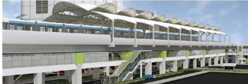
Gambar 2. 20 Fasade Stasiun Blok M (Sumber : www.mrtjakarta.com )
