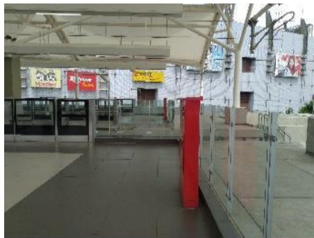
Gambar 2. 15 Utilitas Kebakaran Stasiun Blok M (Sumber : Dokumen Pribadi)
