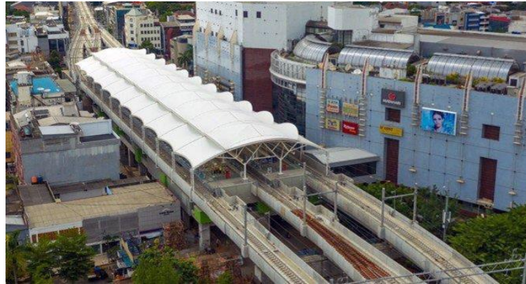
Gambar 2. 2 Stasiun Blok M (Sumber : www.jakartamrt.co.id )
