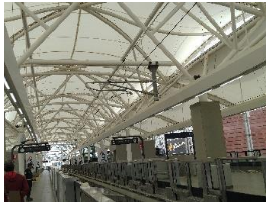
Gambar 2. 17 Utilitas CCTV Stasiun Blok M (Sumber : Dokumen Pribadi)
