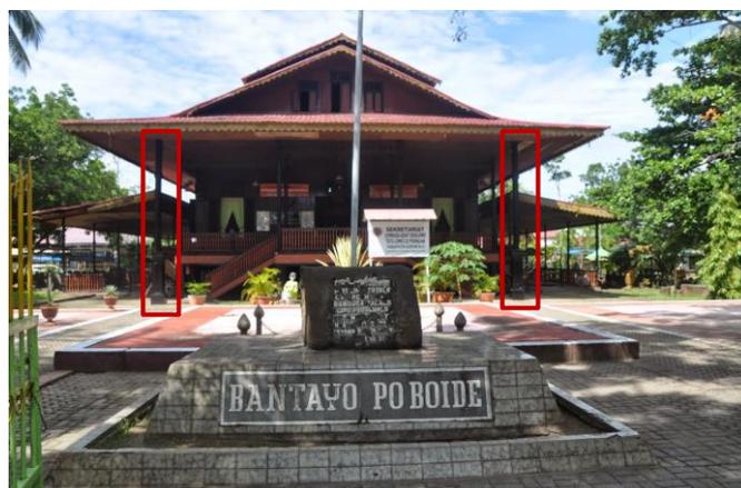
Gambar IV.3 Tiang utama atau *Wolihi* yang menancap dari tanah langsung ke rangka atap
