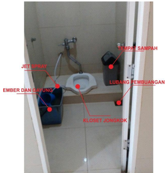
Gambar 28, Kubikal Toilet Jongkok (sumber : Dokumentasi Penulis)
