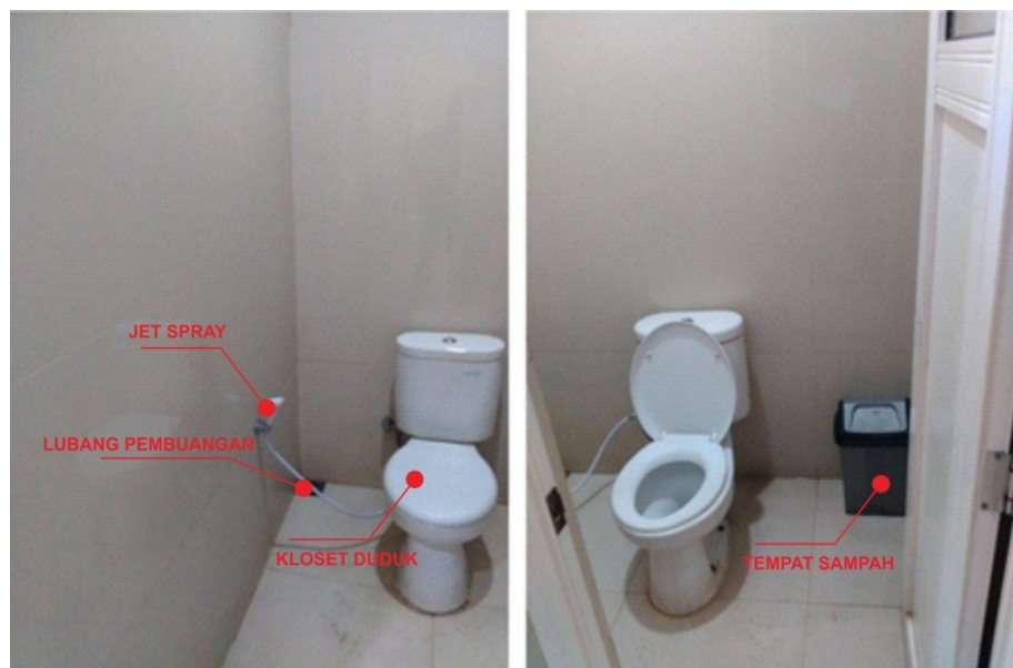
Gambar 27, Kubikal Toilet duduk (sumber : Dokumentasi Penulis)
