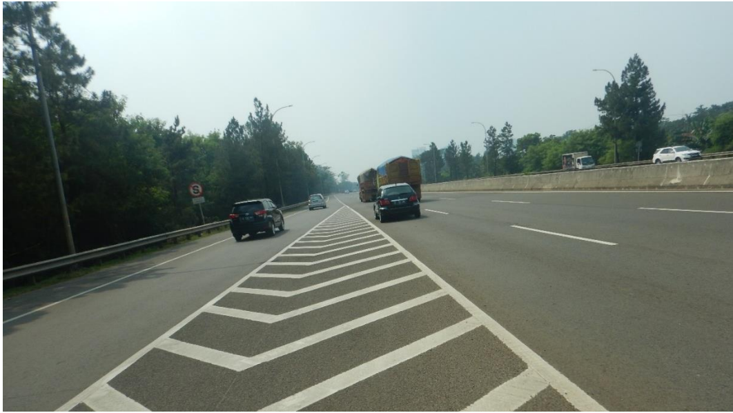
Gambar 3.3 Jalan tol Pondok Aren - Serpong
