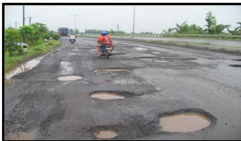
Gambar 2.14 Kerusakan Lubang
