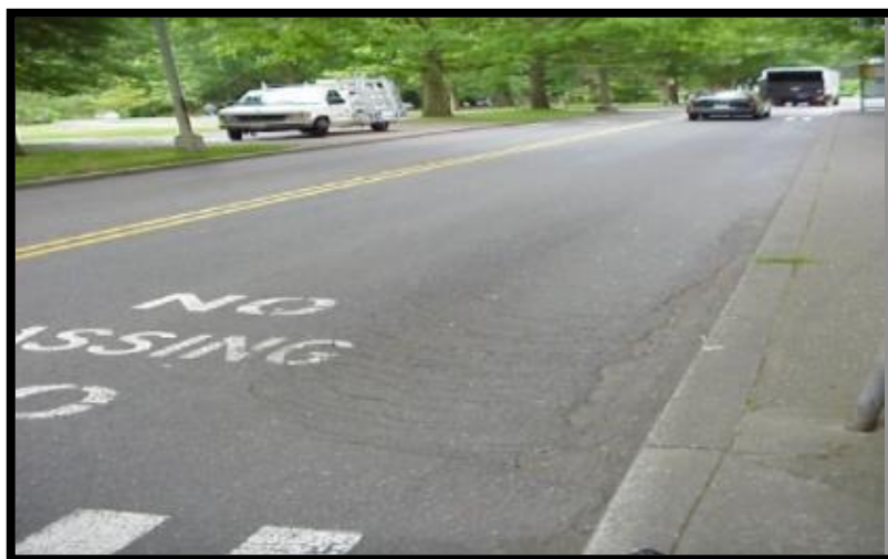
Gambar 2.13 Kerusakan Pengausan Agregat
