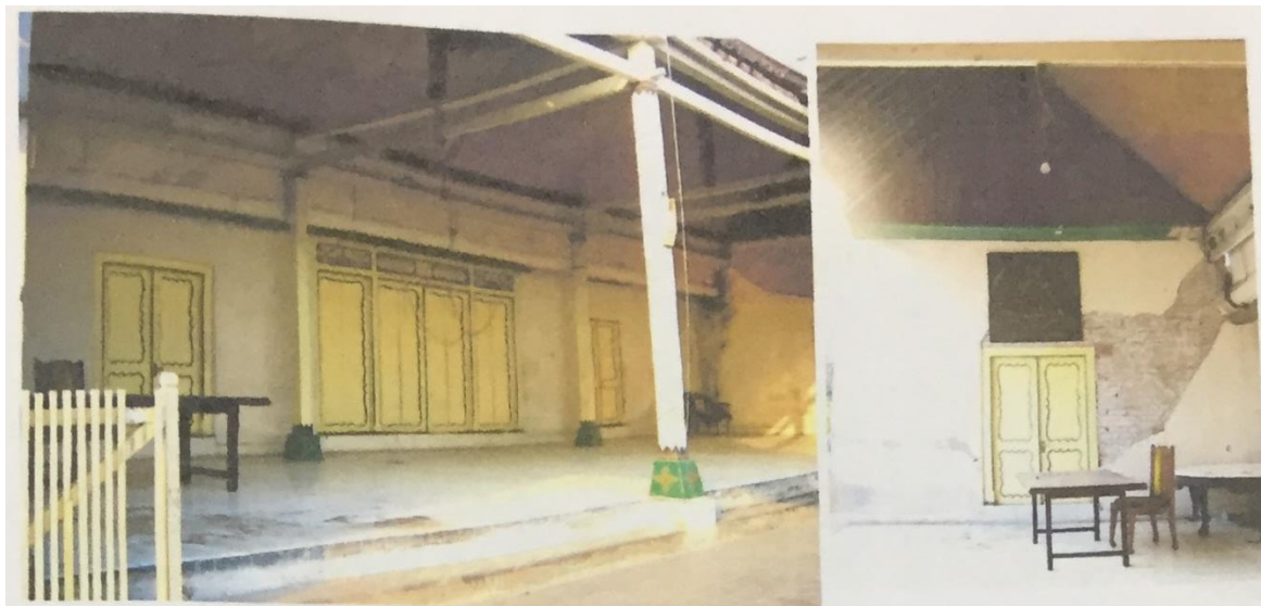
3.7. Bangunan Dalem Yang Digunakan Sebagai Kantor (Sumber : Laporan Tugas Akhir Syarifah Ismailiyah Alatas)
