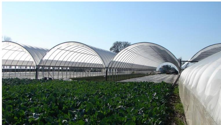
Gambar 4.3 Konstruksi quonset
