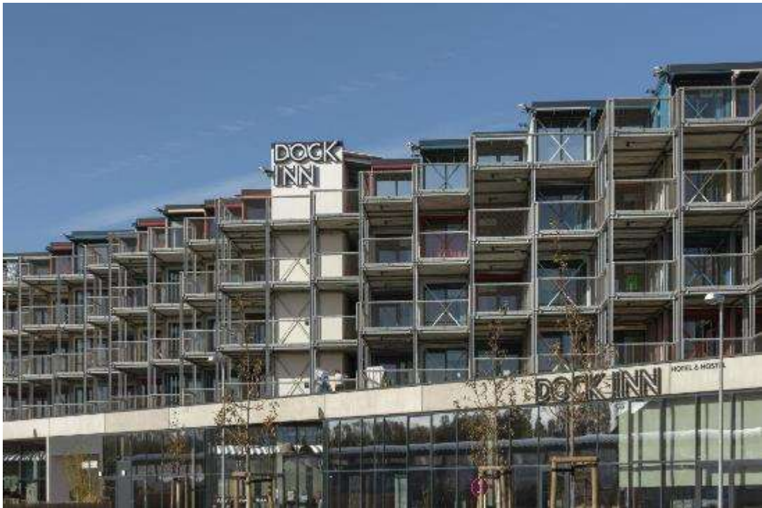
Gambar 7. Fasad hostel Dock Inn yang menggunakan material kontainer. Sumber : holzerkobler.com
