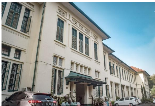
Gambar II.4 Gedung SMUN 3 & 5 karya Wolff Schoemaker Sumber: Dokumentasi Pribadi (diakses pada 25/3/2019)
