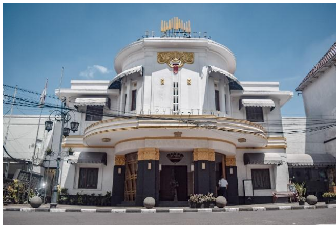
Gambar II.19 Gedung Majestic karya Wolff Schoemaker Sumber: Dokumentasi Pribadi (diakses pada 25/3/2019)
