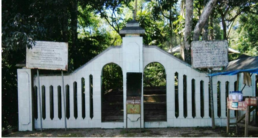
Gambar II.3 Pintu gerbang pertama menuju makam keramat Godog Sumber : Dokumentasi Pribadi (2019)
