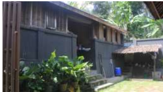
Gambar II.25 Tempat Pengolahan Kue Kering Sumber : Dokumen Pribadi (Diambil pada 24 November 2018)
