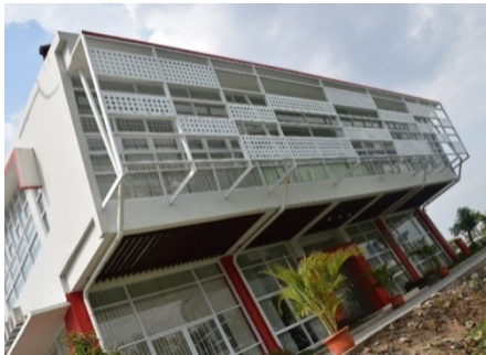
Gambar 4.11 Gedung Business Center Sumber: Hasil Observasi Lapangan 2019
