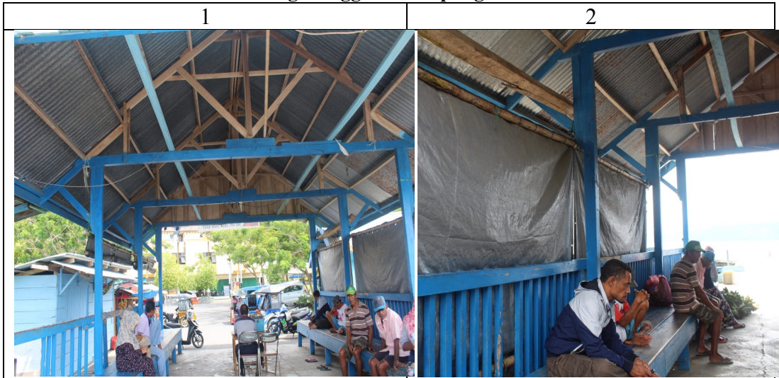
Gambar 4.6 Kedaaan Ruang Tunggu Penumpang Pelabuhan Sarimalaha
