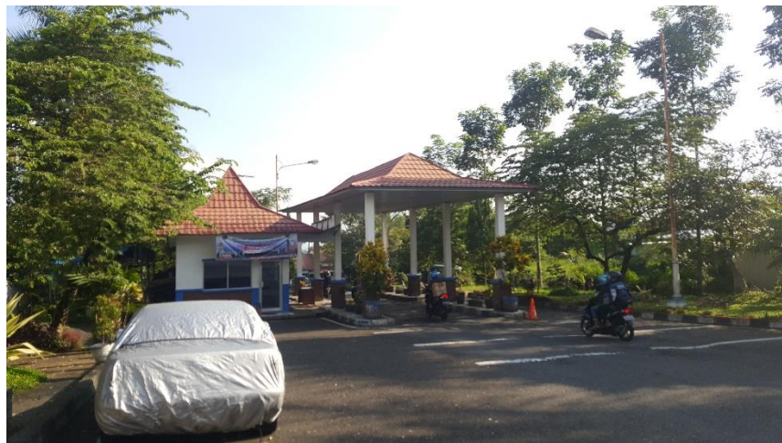
Gambar 2.18 Area Kedatangan Terminal Mendolo
