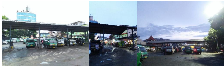
Gambar 2.13 Kondisi Terminal Ledeng
