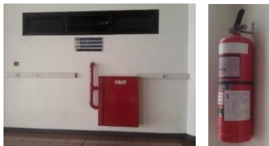
Gambar 2.41 Sistem proteksi kebakaran ( Sumber : dokumen pribadi)
