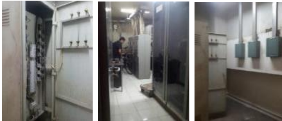
Gambar 2.40 Electrical Room ( Sumber : dokumen pribadi)
