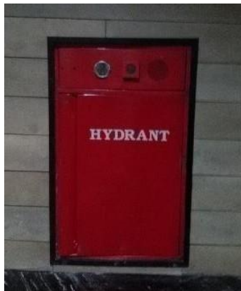
Gambar 2.22 Hydrant ( Sumber : dokumen pribadi)
