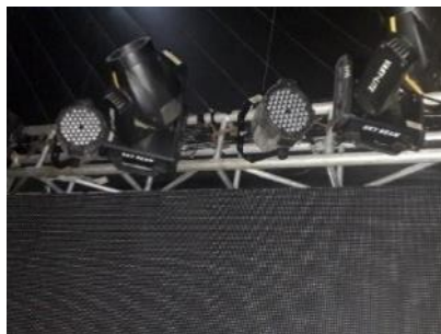
Gambar 2.18 Lighting ( Sumber : dokumen pribadi)
