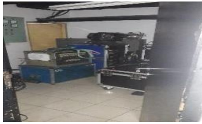
Gambar 2.21 Elektrical Room ( Sumber : dokumen pribadi)
