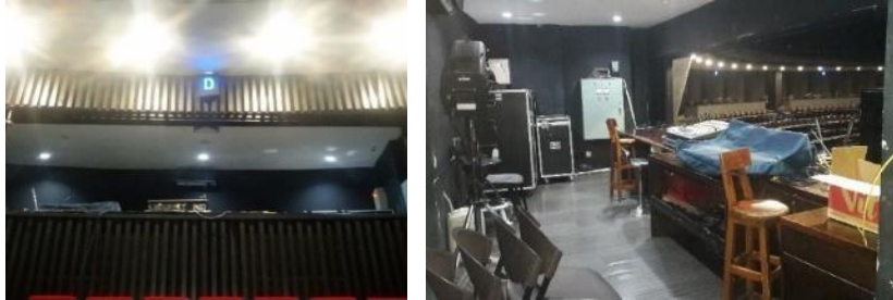
Gambar 2.30 Control Room ( Sumber : dokumen pribadi)
