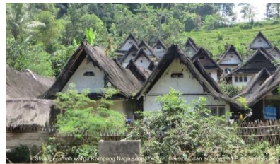
Gambar 5.3.1.3 Atap kampung Naga Sumber : grid.id
