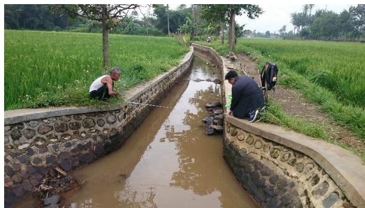
Gambar IV. 7 Pengukuran Dimensi Saluran (sumber: Dokumentasi Pribadi)
