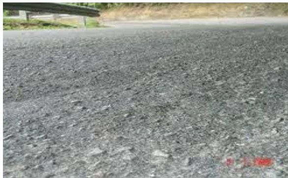
Gambar 2.9. pelepasan butiran
