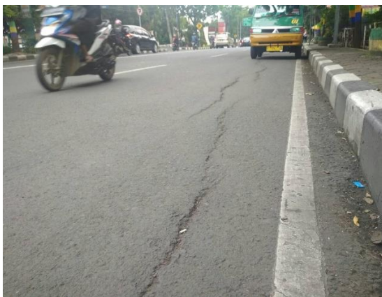
Gambar 2.6. Retak Pinggir
