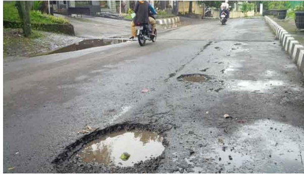
Gambar 2.8. lubang pada jalan
