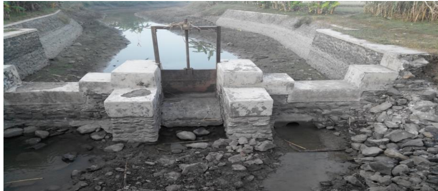
Gambar 2. 5 Bangunan Bendung pada DAM parit & Pintu Air
