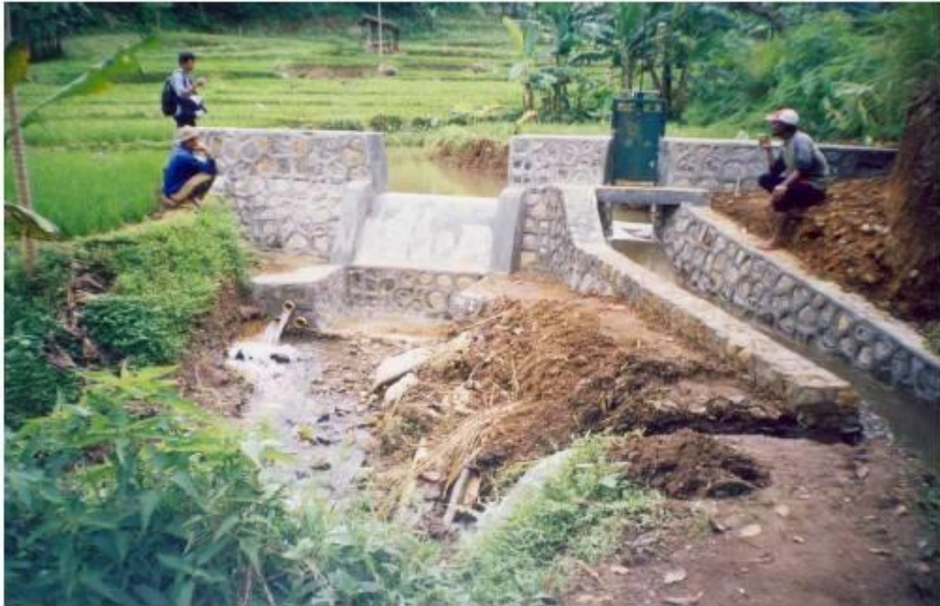
Gambar 2. 3 DAM Parit Tampak Depan
