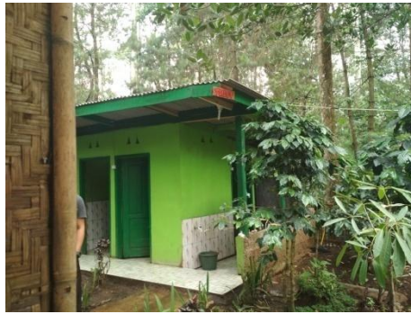
Gambar II.11 Toilet Sumber: Dokumen Pribadi (1 April 2018)
