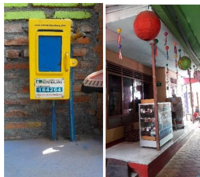
Gambar 2.26 Utilitas kampung Jodipan Sumber : Data pribadi
