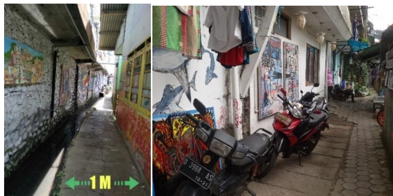
Gambar 2.11 Utilitas Dago Pojok Sumber : Data pribadi
