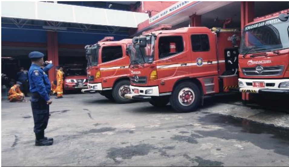
Gambar II.1 Dinas Kebakaran Kota Bandung
